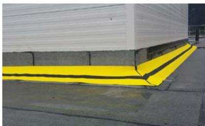
Optimale Anpassung von FlamLINE an Gebäudestrukturen sichern die Dichtigkeit des Bauwerkes.
