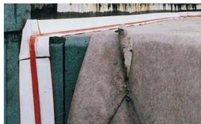
RedLINE wird mit Epoxidharzkleber direkt auf Beton kraftschlüssig appliziert.
