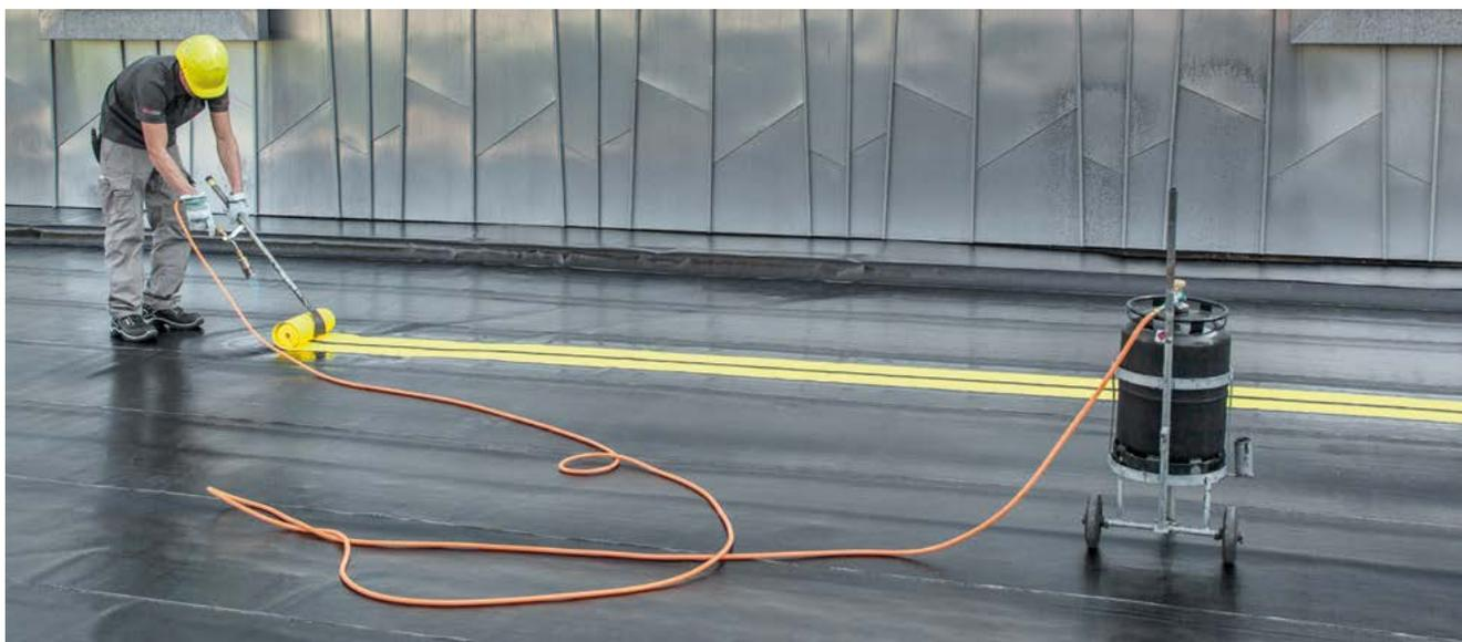
FlamLINE-Fugenbänder werden in der Regel objektbezogen mit sämtlichen Formteilen vorkonfektioniert ausgeliefert. Für Einbauten in mehreren Etappen oder bei sehr langen Gebäudefugen, welche das Handling erschweren, ist das Zusammensetzen auch auf der Baustelle mit dem eigens dafür entwickelten Vulkanisationsgerät möglich. Informieren Sie sich über die Möglichkeiten direkt bei unserem technischen Dienst ([info@soba-inter.com](mailto:info@soba-inter.com)).
