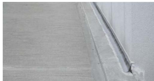
Winkelartiger Einbau mit vorkonfektioniertem Formteil.
