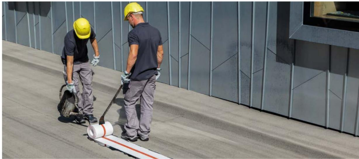
RedLINE-Fugenbänder werden in der Regel objektbezogen mit sämtlichen Formteilen vorkonfektioniert ausgeliefert. Für Einbauten in mehreren Etappen oder bei sehr langen Gebäudefugen, welche das Handling erschweren, ist das Zusammensetzen auch auf der Baustelle vor Ort mit dem eigens dafür entwickelten Vulkanisationsgerät möglich. Informieren Sie sich über die Möglichkeiten direkt bei unserem technischen Dienst ([info@soba-inter.com](mailto:info@soba-inter.com)).
